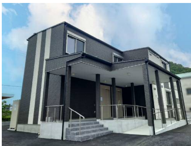
障がい者グループホーム外観
